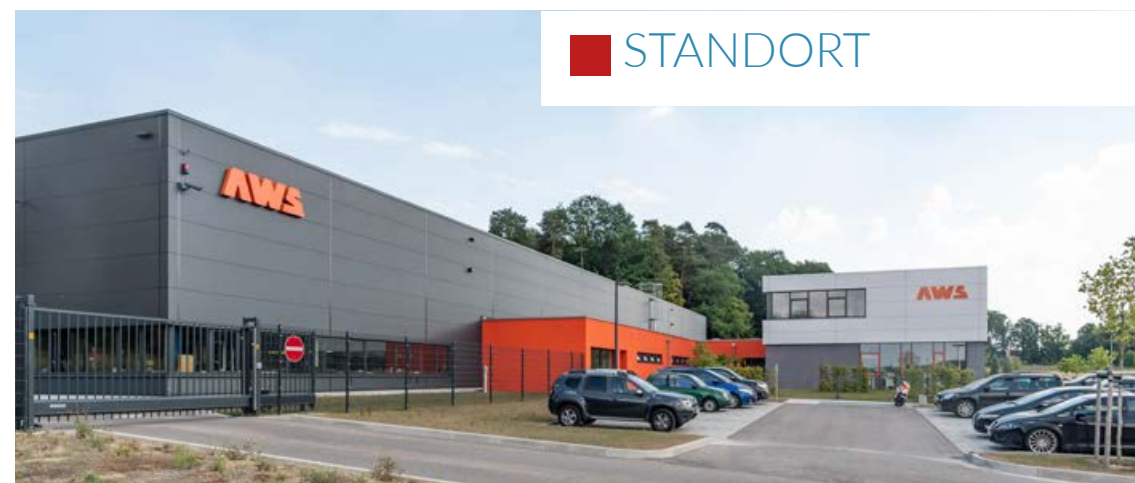
© AWS Fertigungstechnik GmbH
